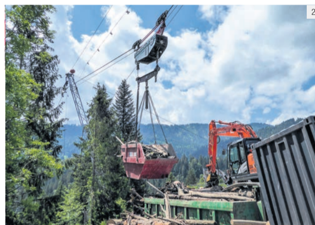
1: Die Treppe im hellblauen Gerüstturm ist Arbeitsweg des Kranführers und Notausstieg zugleich. 2: Die volle Mulde wird zum Umschlagplatz hochge-seilt und dort gekippt. 3: Rudolf Stoller (l.) und Hansjürg Lauber begannen im Herbst mit den Vorarbeiten. 4: Zur Sicherheit mussten erst Steinschlag-netze angebracht werden.
